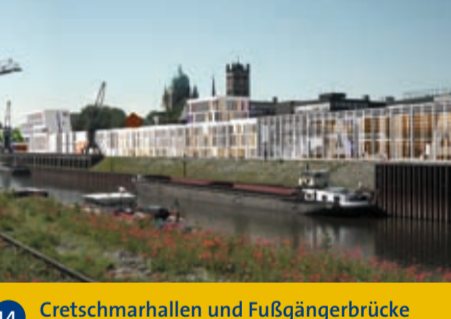
14 Cretschmarhallen und Fußgängerbrücke Lichtdurchflutet: Hier gibt es viel Platz für Büros, Gastronomie, Gewerbe und Veranstaltungen.
