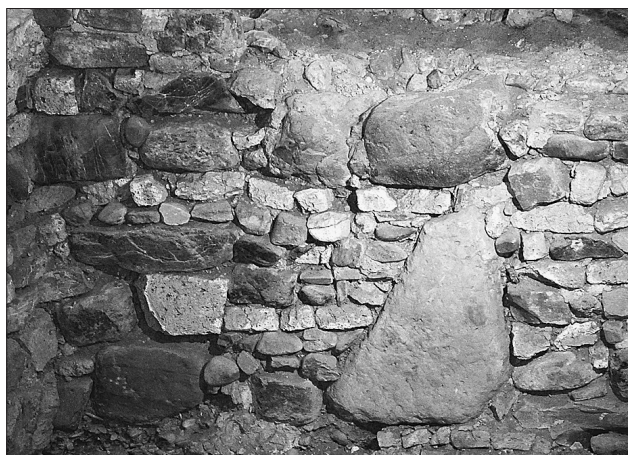
△ Abb.6: Neuss, Brückstraße. Keller des 12. Jahrhunderts, erbaut aus wiederverwendeten römischen Bausteinen.
