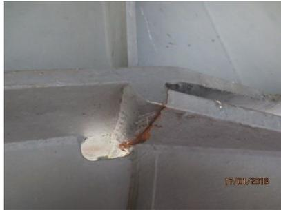
Provisorische Reparatur von festgestellten Mängeln in beiden Fahrtrichtungen (Punkte 1 bis 3 innen und außen) bis August 2019 unter 2:2-Verkehrsführung, um die 3:1-Verkehrsführung einrichten zu können
